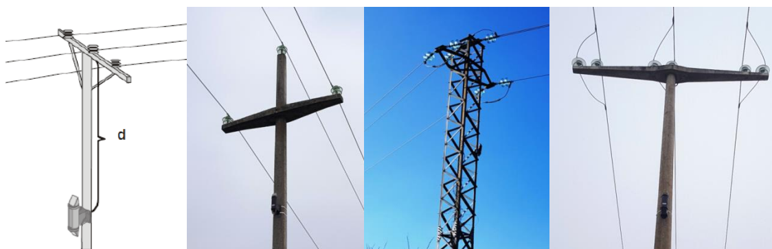
Slika 4. Konfiguracija zračnih vodova
