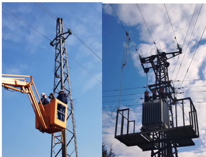
Slika 8. Postupak ugradnje indikatora kvara na vod
